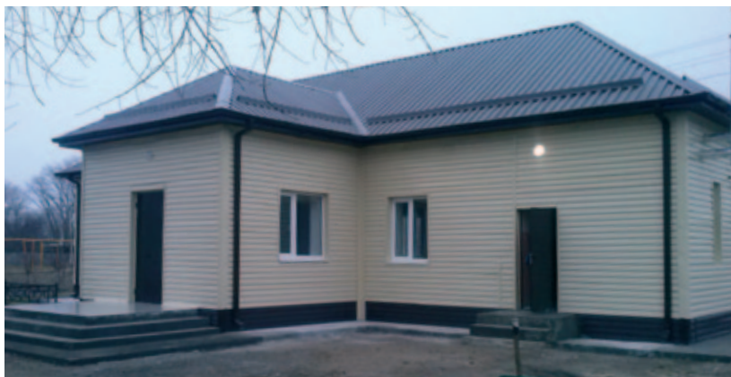
Отремонтированное здание Дома культуры х. Широкий Камыш, Ростовановское, Ставропольский край
